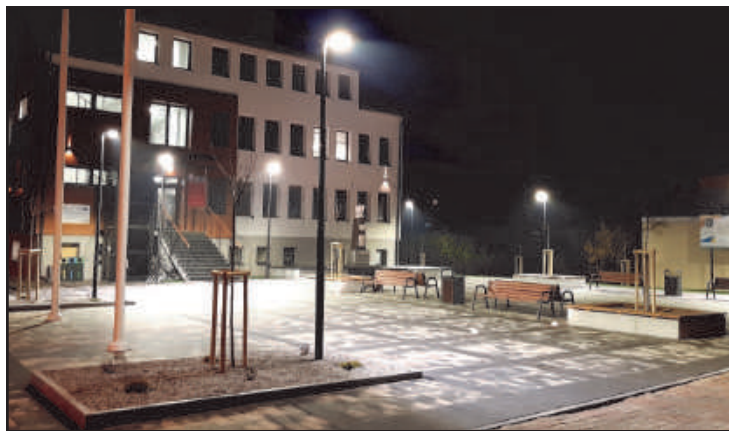
Plac i budynek Urzędu Miejskiego w Szepietowie
