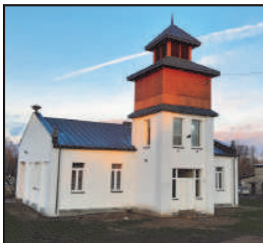
Dąbrówka Kościelna - Remiza elewacja
