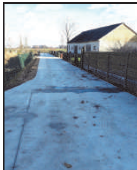
Jabłoń - Kikolskie - Droga betonowa
