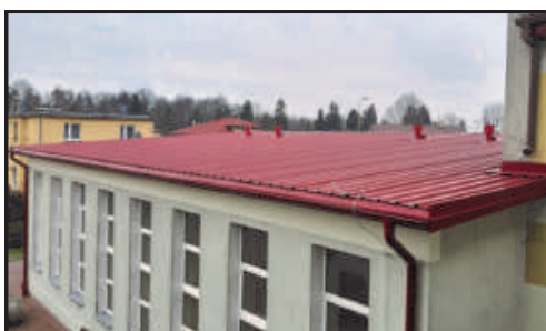
Szepietowo - Remont dachu w SP
