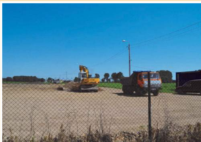
Na placu budowy biogazowni
