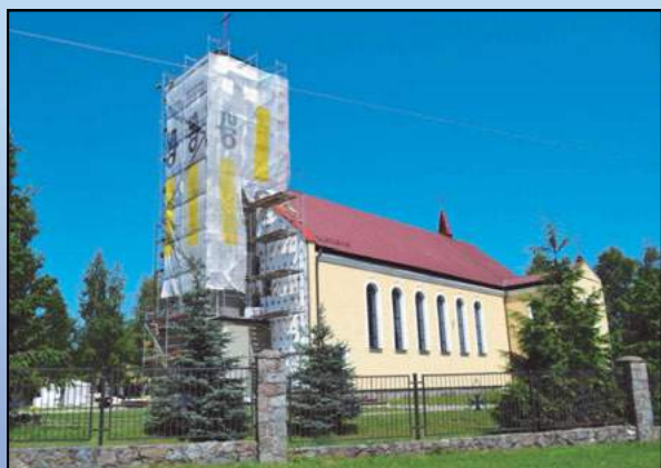
Prace przy termomodernizacji kościoła w Wojnach Krupach
