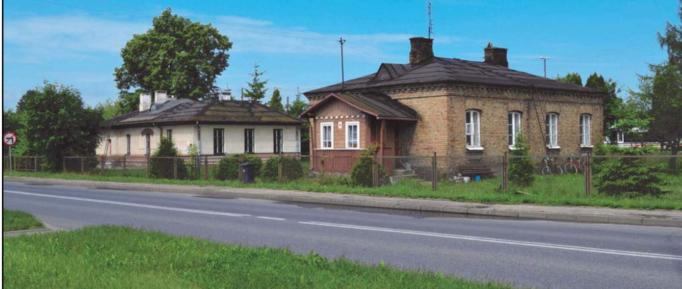
Budynek dworca PKP i mieszkalny proponowany przez PKP do przejęcia przez gminę.
